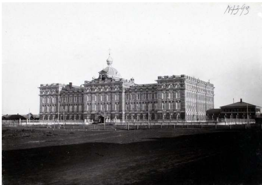
Рис. 1. Епархиальное женское училище г. Елабуга. Центральный фасад. 1903 г. (фото из фототеки ГАКО г. Киров)
