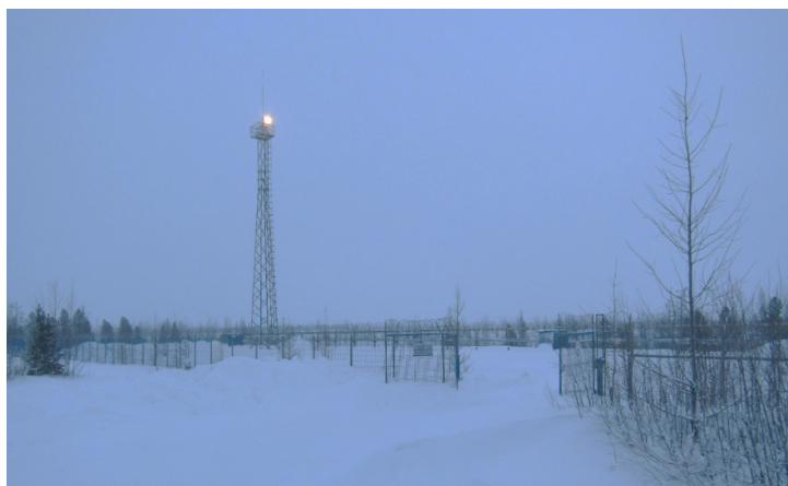
Рис. 2. Водозабор Пуртазовской промплощадки
