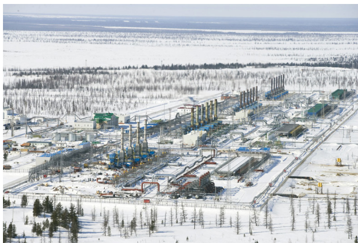
Рис. 1. Компрессорная станция «Пуртазовская»
