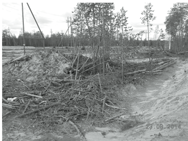
Рис. 4. Порубочные остатки. Етыпуровское месторождение
