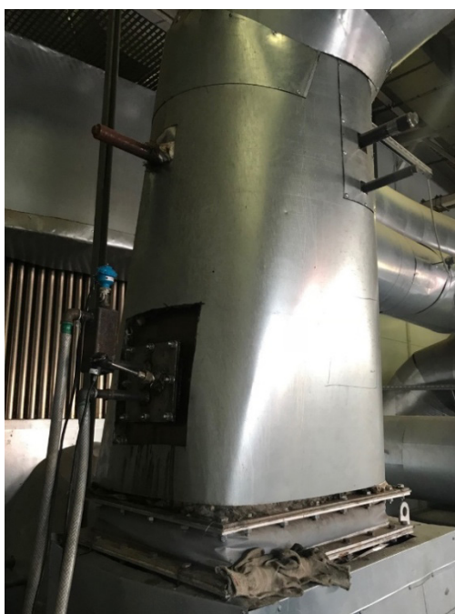
Рис. 3. Применение теплообменного аппарата с ребристой поверхностью для передачи тепловой энергии от парогазовой смеси в воздуховоде. Движение парогазовой смеси происходит снизу вверх
